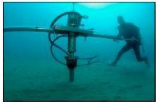
Vissage direct par clé hydraulique
