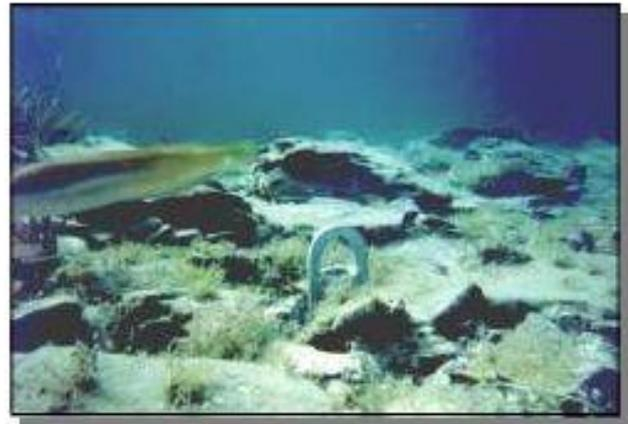
Tête affleurante d'un ancrage installé dans un éboulis
