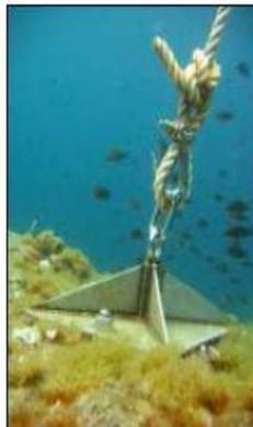
Pour un substrat dur (roches, etc.), des perforations à des profondeurs appropriées sont exécutées, suivi de scellements de tirants acier inox. Enfin, la pose d'un anneau simple ou d'une platine d'ancrage inox renforcée, boulonnée sur les tirants scellés complète le procédé.
