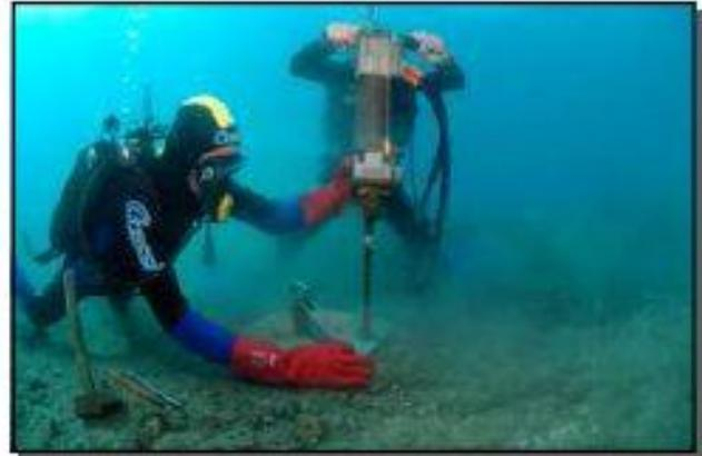
Perçage de la roche avec perforateur hydraulique
